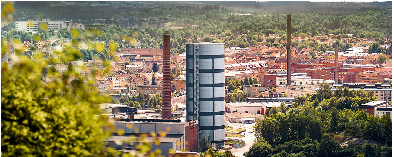
Bild på Ryaverket och dess ackumulatortank med varmvatten
